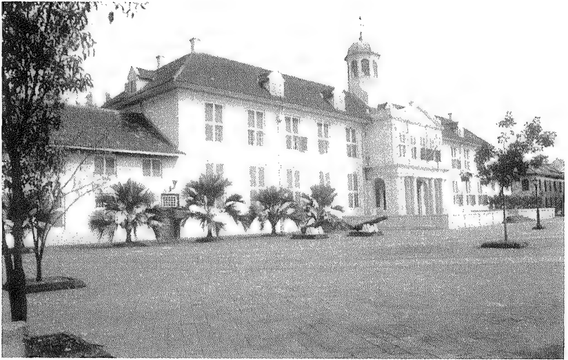
Gedung balai kota Batavia, dibangun pada 1710, sekarang dipugar di tempat lama di Jakarta modern
